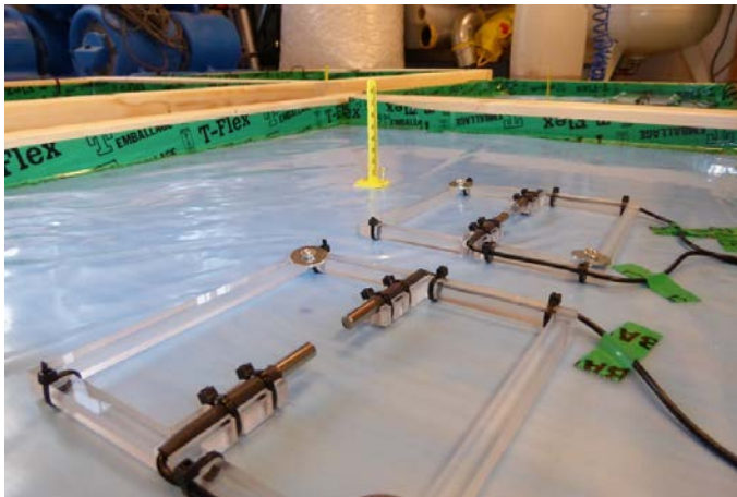
Bild 21: Närbild av FC-givare på underlag av plastfolie före gjutning.
